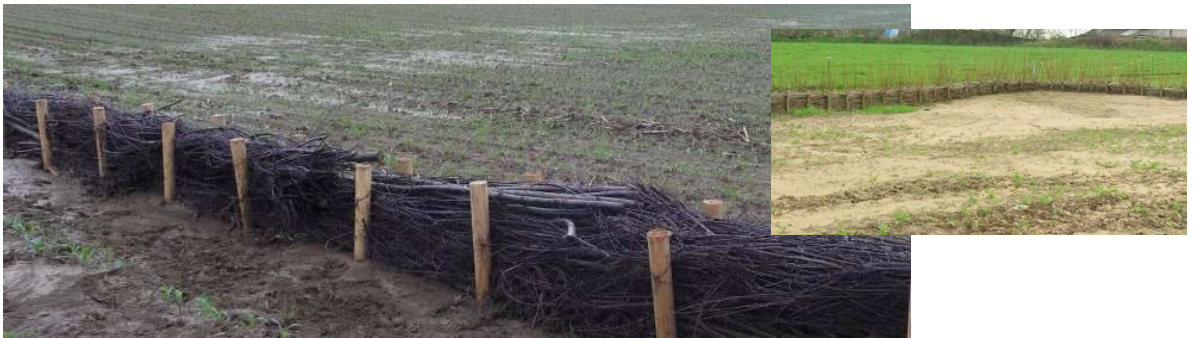
Photo 19 : fascine en plein champ (encart : dépôt sédiment au droit d'une fascine)
