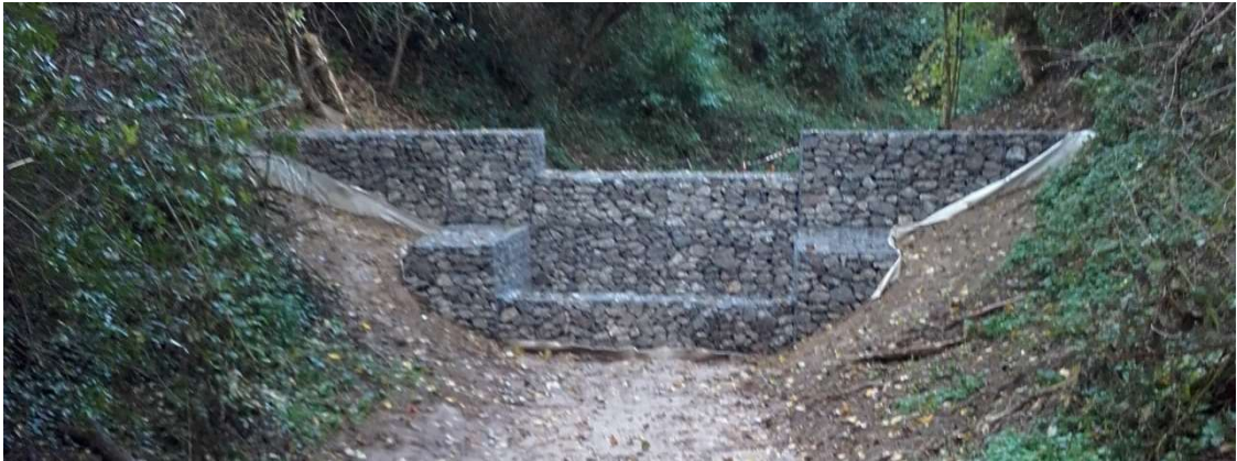
Photo 26 : exemple d'un gabion
