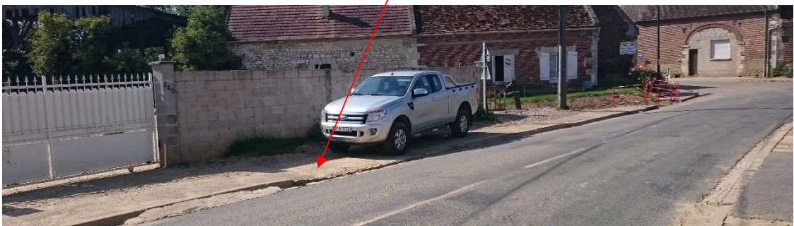
Photo 6 : point de mesure du trottoir au n°240 rue Saint Rémy
