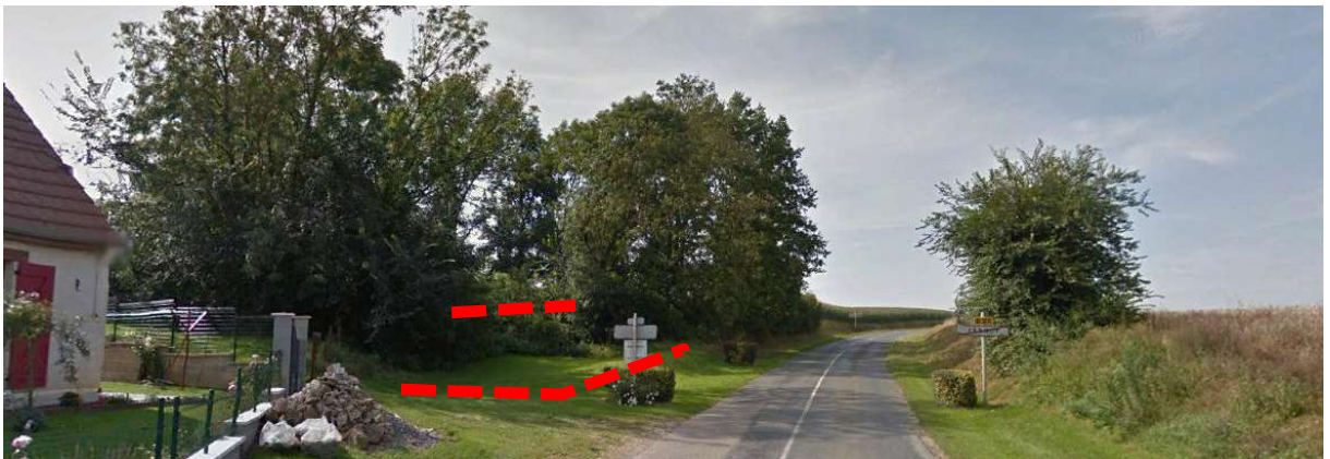
Photo 25 : localisation des gabions « ga4 et 5 »
