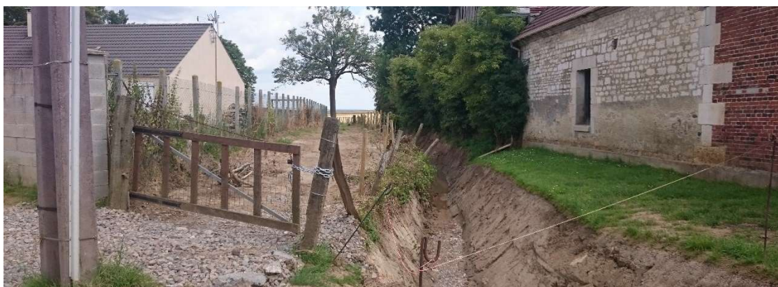
Photo 35 : fossé aval de la rue Saint Rémy
