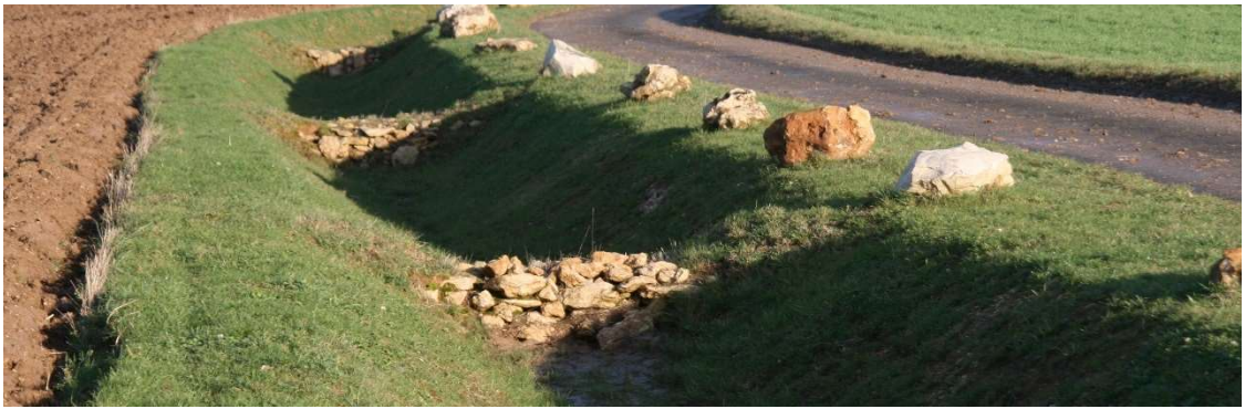
Photo 16 : exemple de fossé à redents
