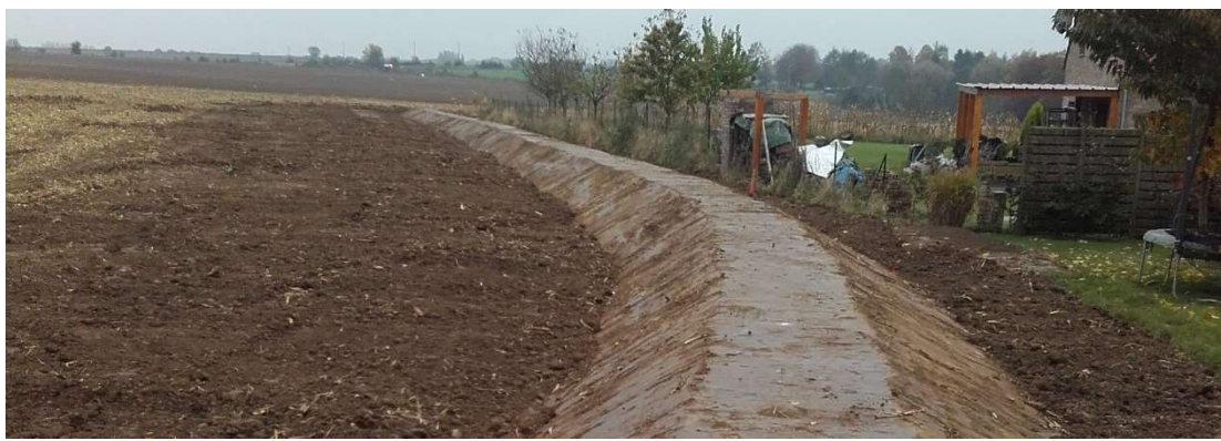
Photo 22 : exemple de merlon en limite de jardin
