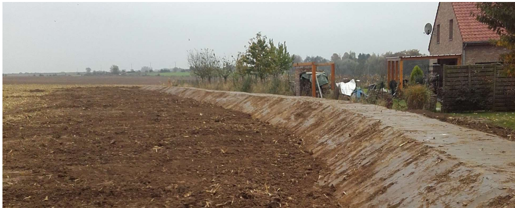
Photo 14 : exemple de merlon de protection
