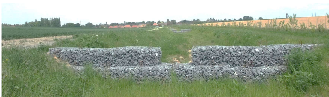
Photo 10 : exemple d'un seuil en gabion
