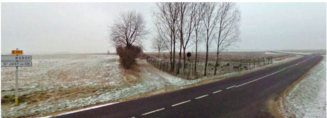
Photo 37 : bassin d'orage à l'intersection D 101 et D 532 (source Google Earth)
