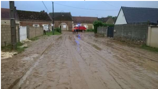
Boue sur chaussée (rue Saint Rémy)
